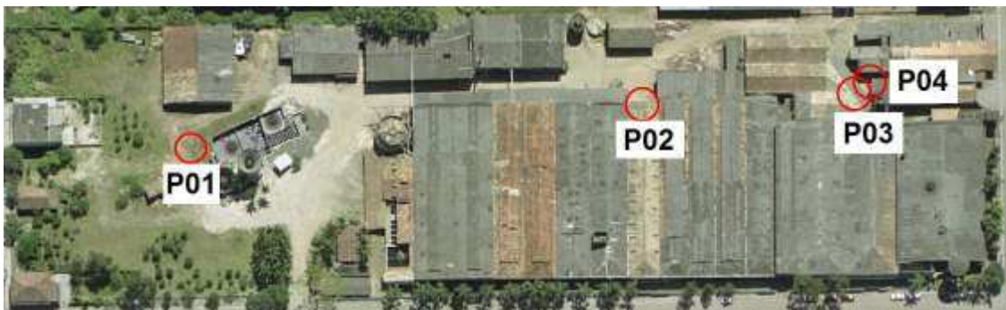
Figura 24: Foto aérea da área do curtume Dal-Bó com identificação dos pontos de coleta de amostras de solo.
